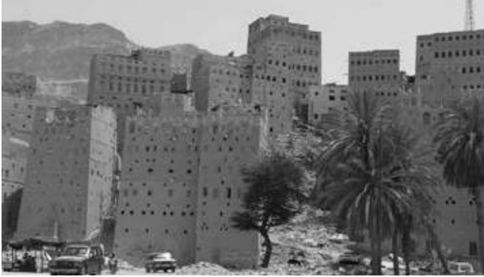
شكل 12: صورة لمباني شبوة الطينية
