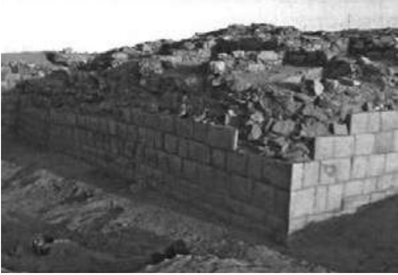
شكل 24: الجدران الخارجية لأساسات مبني في مدينة تمنع بنيت بتقنية الجدران المزدوجة بالحجارة المشدبة
