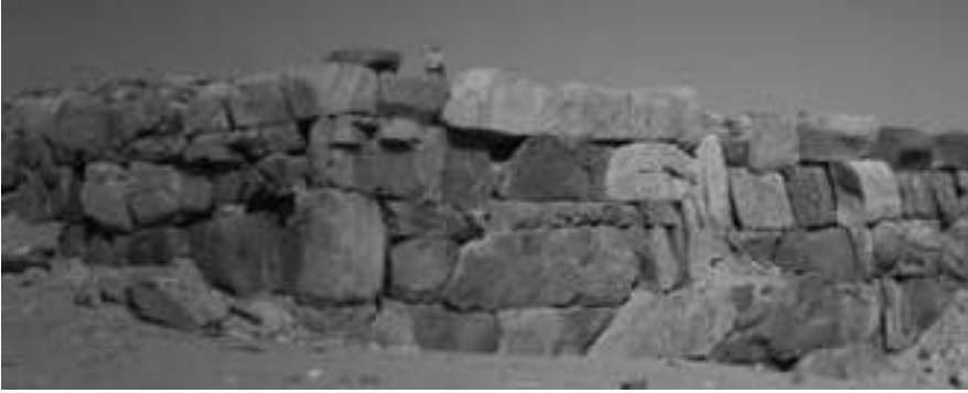
شكل 17: أساس مبنى في مدينة تمنع
