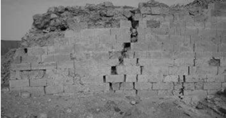
شكل 26: مبنى في مدينة شبوة القديمة بني بتقنية الجدران المزدوجة بالحجارة المصقولة
