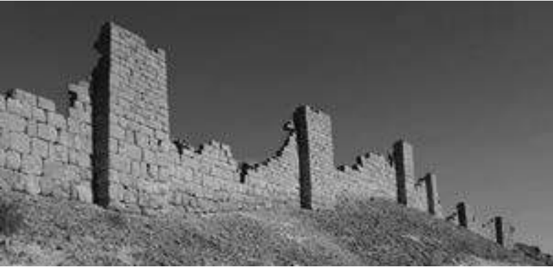
شكل 25: سور مدينة ميفعة بني بتقنية الجدران المزدوجة بالحجارة المشدبة
