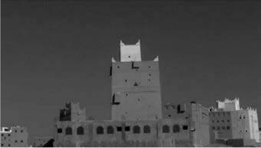
صورة (4) احد الحصون الطينية بمنطقة الجابية وتظهر فيه النوب والبواشير
