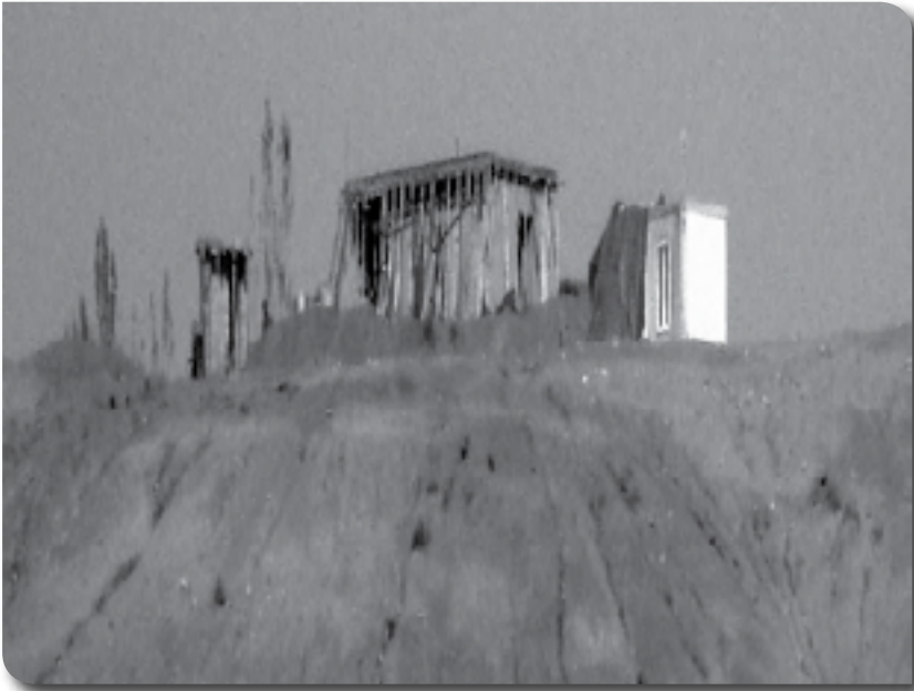
(صورة رقم - 5 -) صورة تجاوز لبناء حجري وكونكريتي حديث قيد الإنشاء
