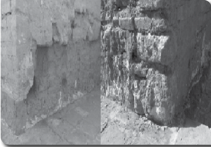
صورة رقم - 8 - أعمال صيانة احد جدران الأبنية العمرانية في مدينة نمرود، عدسة الباحث
