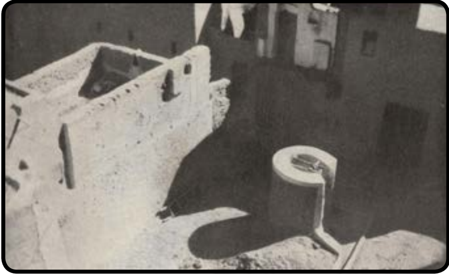
منازل طينية بها صهريج (خزان مياه) بحضرموت
